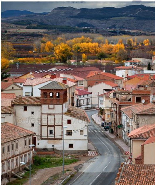
Antigua puerta de Daroca
